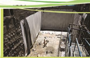
پروژه زهکشی مجتمع تجاری اداری برستان
