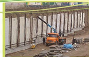
پروژه زهکشی انباران اتمام نقش
