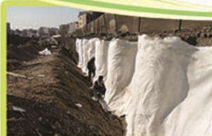
پروژه زهکشی زیر کار پارکینگ اتمام
