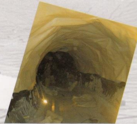
پروژه ایزولاسیون تونل انتقال کابل قیطریه
