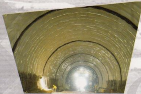
پروژه ایزولاسیون و زهکشی تونل صدر و نیایش
