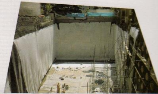
پروژه ایزولاسیون و زهکشی مجتمع تجاری پرشیا
